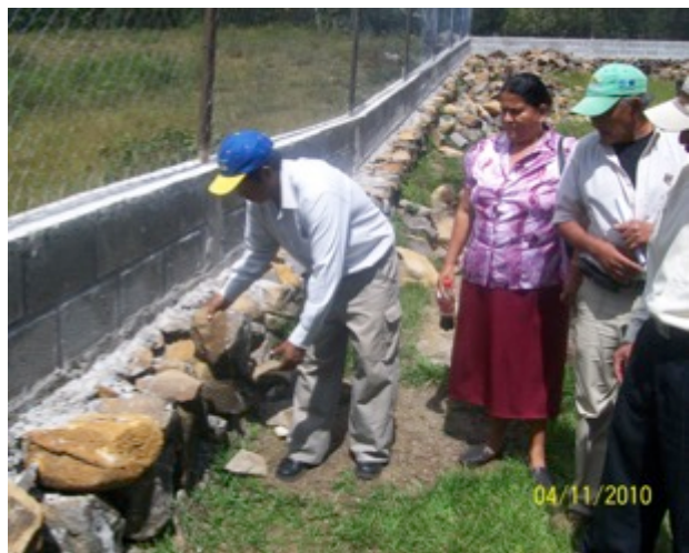
Visite sur le terrain d'une commission pour contrôler la qualité d'un chantier
